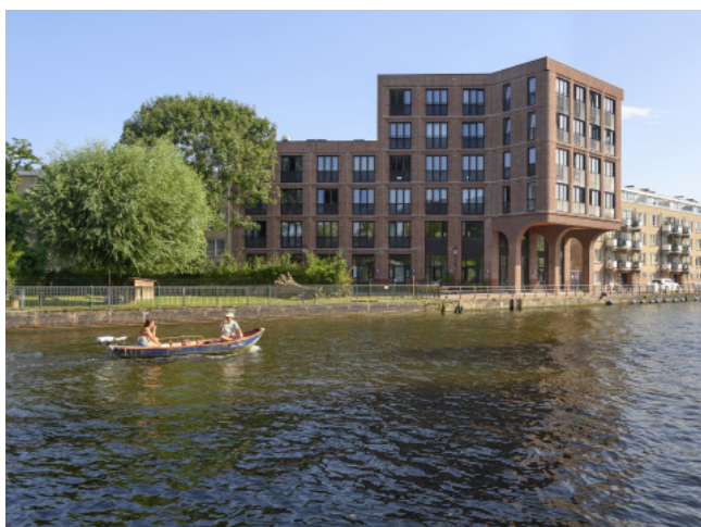
Nieuwbouw aan de Tweede Kostverlorenkade
